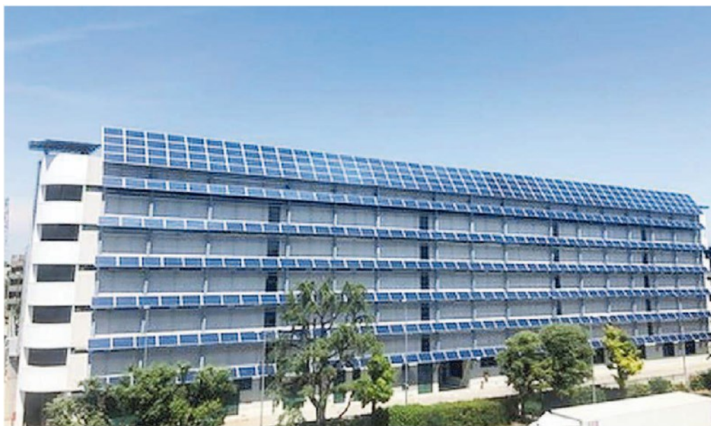
La sede di InfoCamere in corso Stati Uniti ricaverà energia da 900 metri quadrati di pannelli fotovoltaici
